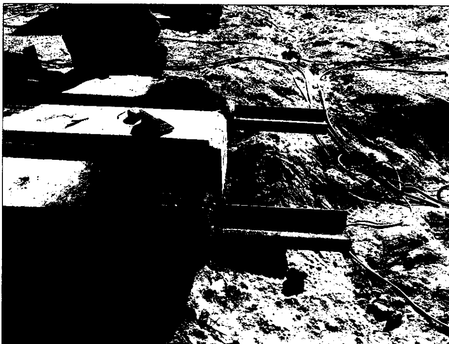
01.01.01.01 PUNTA METALICA DE PILOTE PARA FACILITAR HINCADO
